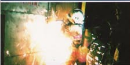
сварочные работы, окурки
